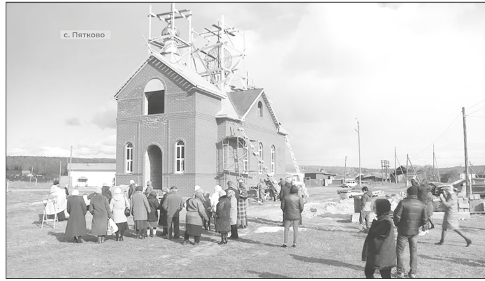
Строительство нового храма в с. Пятково
