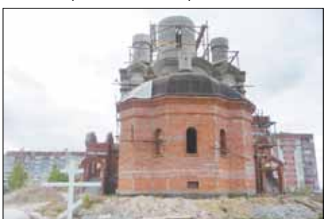
Храм на этапе строительства, май 2010 г.
