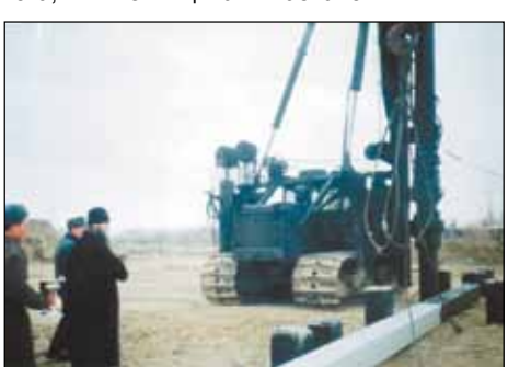
29 октября 2004 г. под фундамент здания храма забита первая свая
