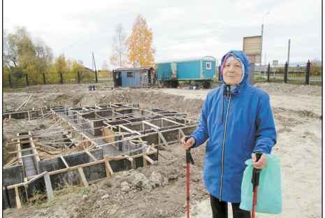
На месте строительства нового храма. 3 октября 2019 г.
